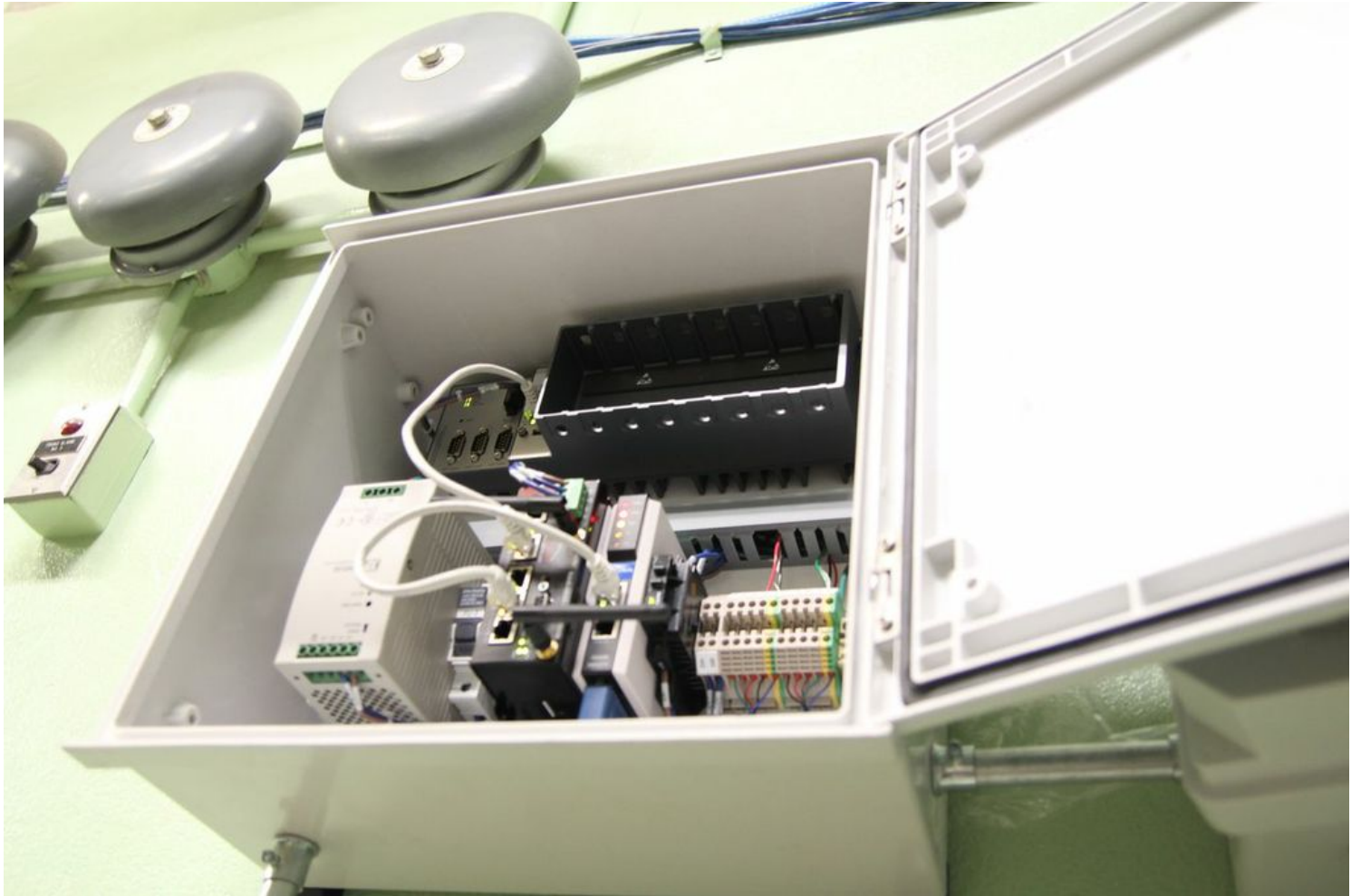
图2：已部署的 LocalGrid 单元控制器
